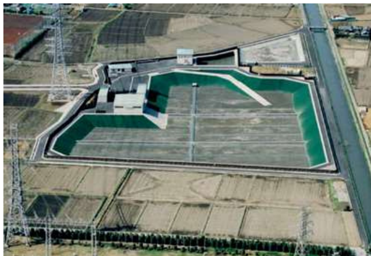
最終処分場建設時
