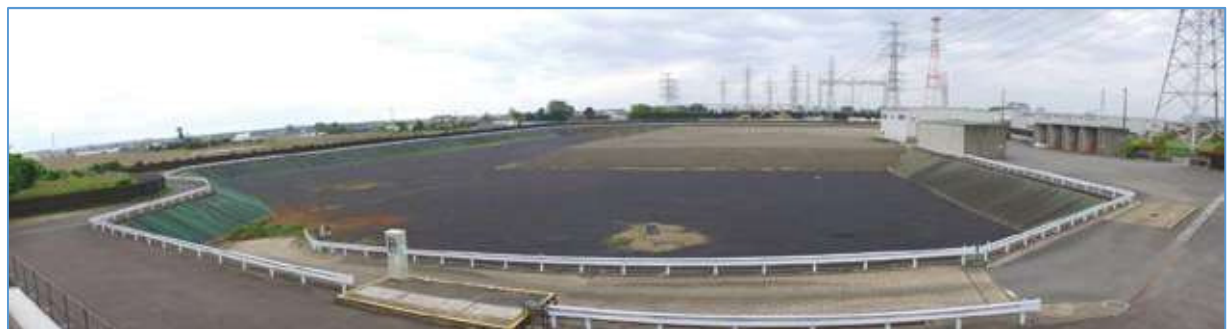
水処理施設から撮影
