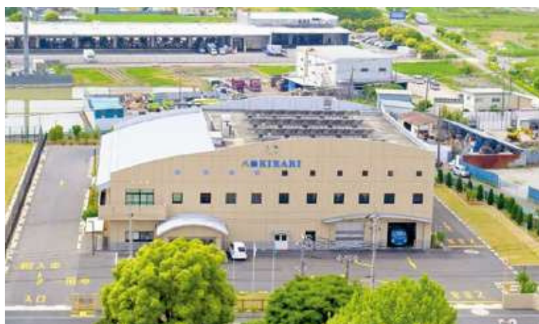
第二工場汚泥再生処理センター 正面玄関
