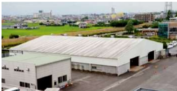
破碎処理棟・発酵棟
