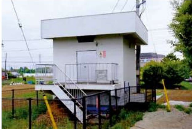
元荒川ポンプ場 正面入り口
