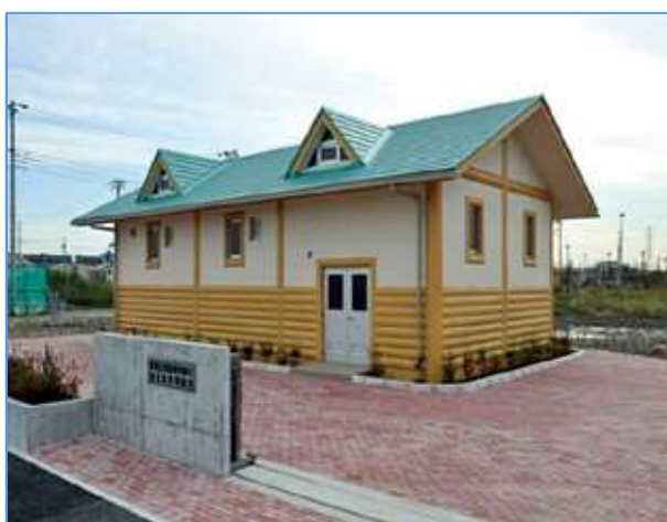
浸出水処理設備の外観
