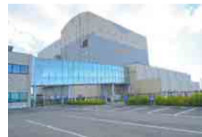
第二工場ごみ処理施設
