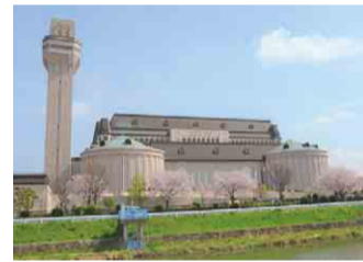
第一工場ごみ処理施設
