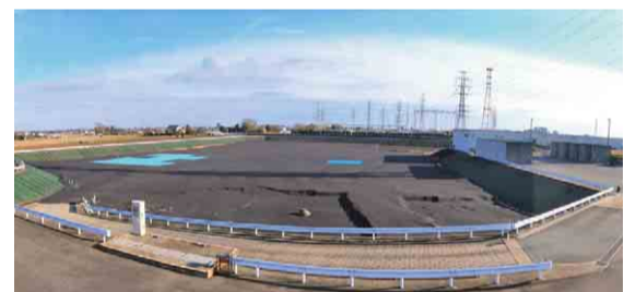
第二最終処分場
