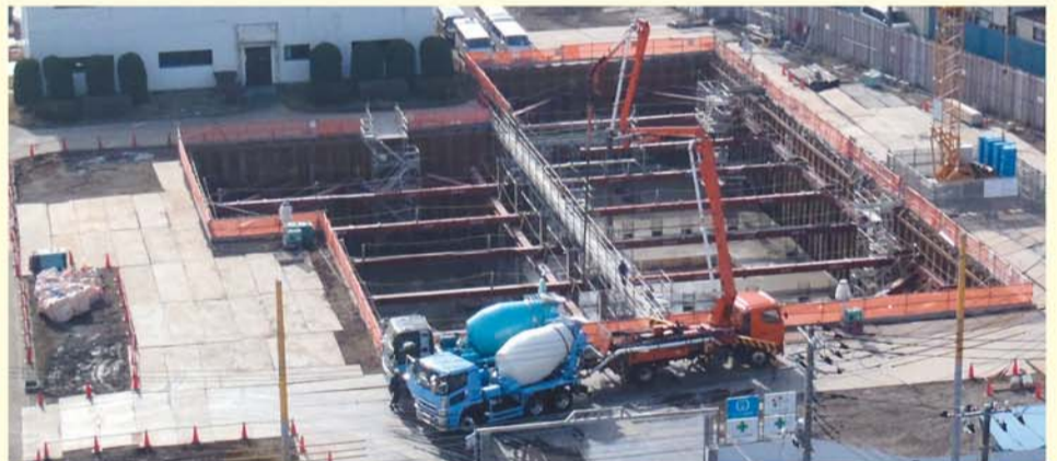
【第二工場ごみ処理施設より撮影した現場状況】
