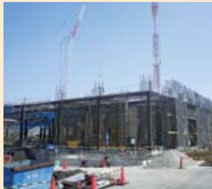
●施設の鉄骨建方及び鉄筋組立て、型枠設置や外部足場の組立作業状況
