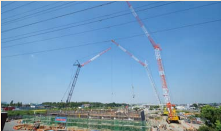
●クローラークレーン3基による資材吊り込み作業状況
