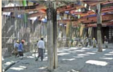
●底盤部のコンクリート打設状況
