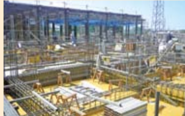
●施設の鉄筋組立て及び型枠設置作業状況
