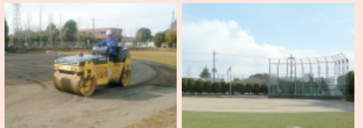
溶融スラグの敷設工事中
